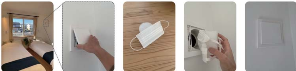
①みやこの家2階寝室。花粉は寝ている時にも！ ②換気口の蓋を外して、フィルターを取り除く。 ③換気フィルターにマスクをつける図 ... エモ。 ④換気口に戻して。 ⑤蓋をして完了！簡単！花粉除去率パワーアップ
