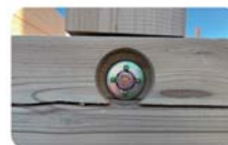
①構造用金物のあるところに施工します
