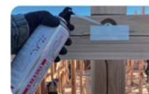
②ウレタンの膨らみを抑えるために気密テープを先に貼ります
