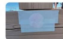
③その後、構造用耐力壁面材を施工します
