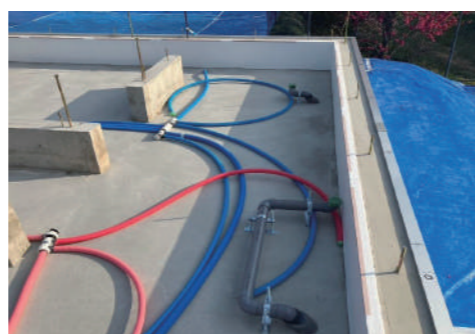
ブロック状の束工法を活かし、一部の壁立上りに変更 給排水管の設置やメンテナンスのしやすさを継承
