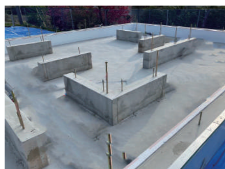
ブロック状の束工法を活かし、一部の壁立上りに変更 給排水管の設置やメンテナンスのしやすさを継承
