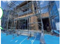
10月完成に向けて順調に 工事が進んでいます。
