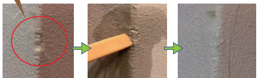
角が欠けた(>_<) 水で練った珪藻土を塗付け 目立たなくなりました！
