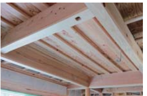
燻煙乾燥した美しい梁がリビングのアクセントになっています。
