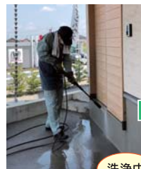
基礎の汚れも 目立ってきたので洗います！
