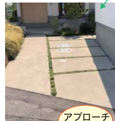
アプローチ 洗浄後
