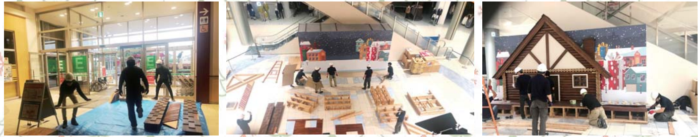
早朝 6 時 30 分 スタッフ現地集合!! いざセントラルコートにて搬入作業です。
