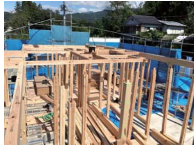
柱と梁の工事の様子
