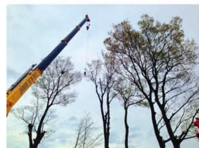
高さ 20m、直径 80cm の榎木の高木です。いきなり倒せないで、吊るし切りでの作業となりました。
