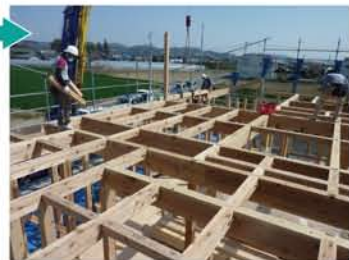
加工した柱や梁を大工さんが組み立てる（建て方）
