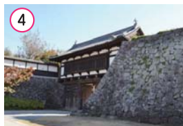
4 小諸城の石垣・・・ 石の上に建てることもできた。
