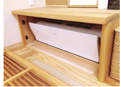
壁掛けエアコンを床に配置！ 普段は見えないようになってます。
