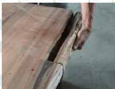
傷んだ部分の穴を埋め、きれいに補修します
