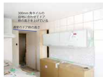
難しかった内装タイル貼りの様子
