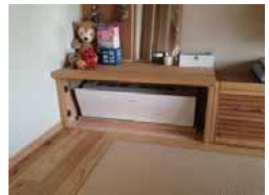
床下に吹き出すように壁掛けエアコンを設置しました。
