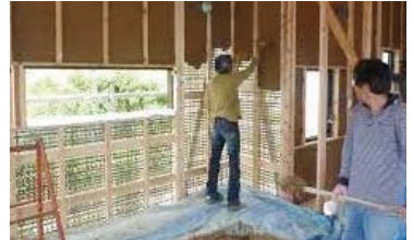
土壁を塗っている様子
