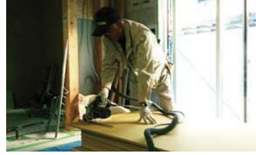
石膏ボード切断作業中の新井大工さん
