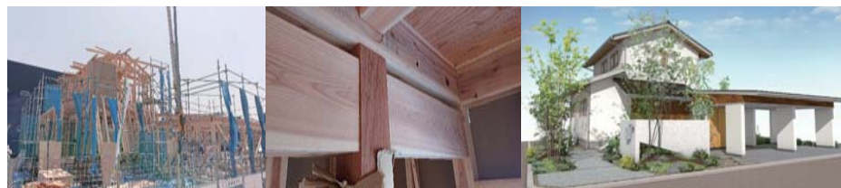
建方工事の様子
