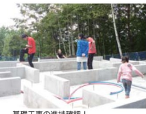
基礎工事の進捗確認！ 視度で歩けるくらいキレイな仕上がり
