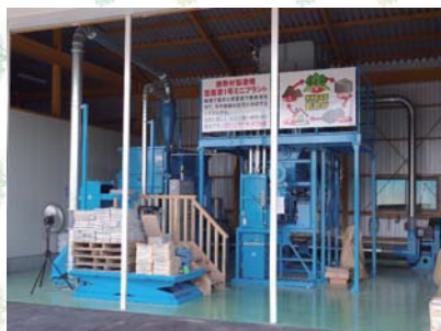
沼田市 斉藤林業「エコファクトリー」
