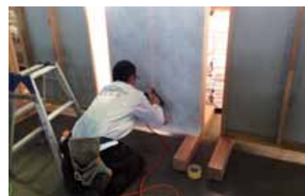
競技会断熱シート貼り風景です。
