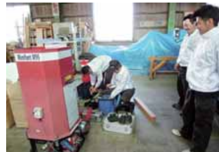
ブローイングマシンの点検から闘いが始まっています。
