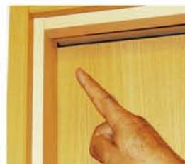
新建材の仕上げ(他社)
