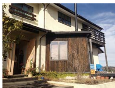
ウッドデッキに繋がる三角コーナ
