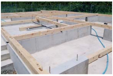
設置後の土台の様子
