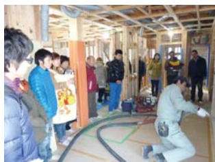
セルロースファイバー断熱材の施工実演。断熱・調湿・防音の効果を左右する大事な工事です。
